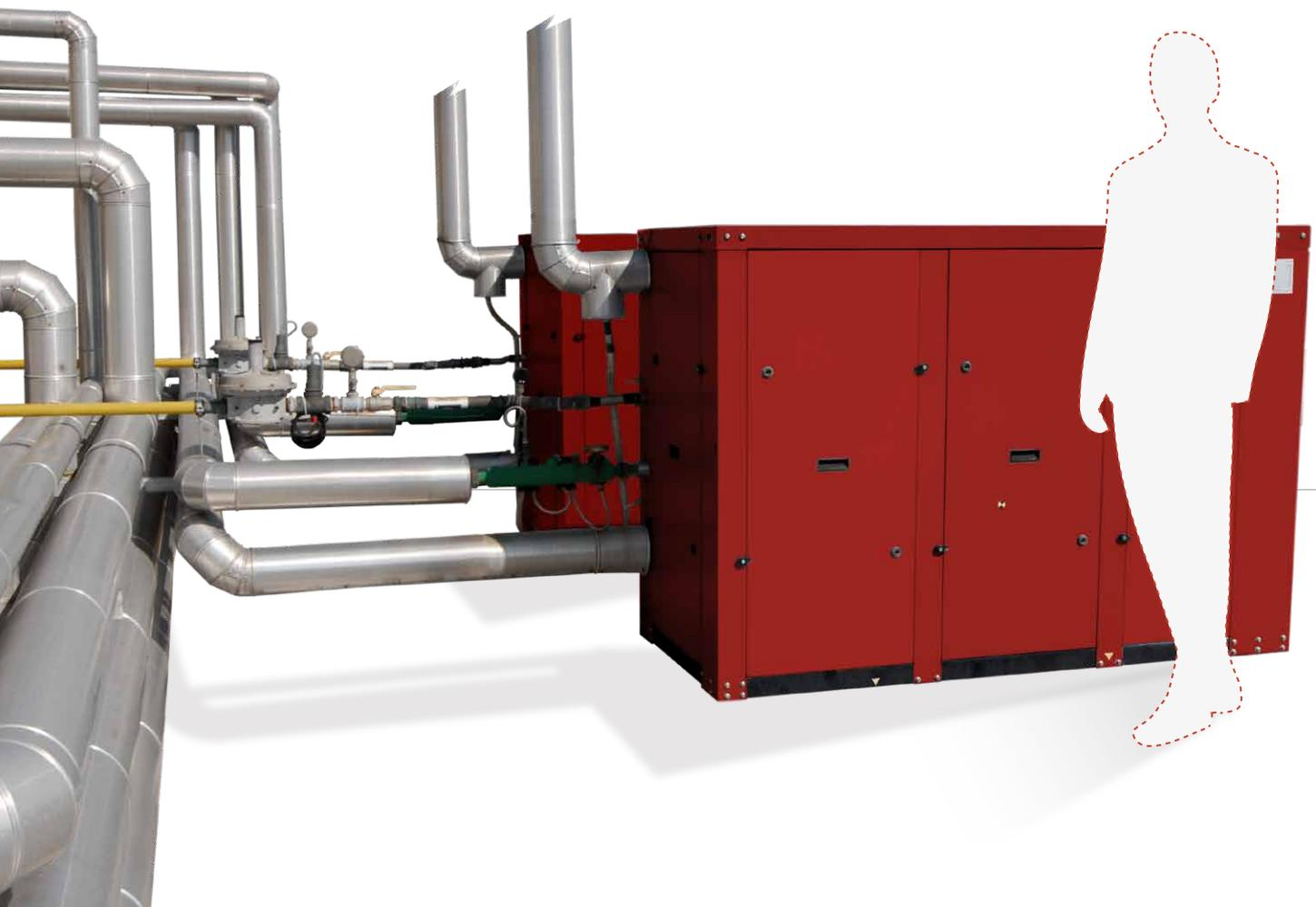
Il microgeneratore TOTEM produce elettricità quando vi è una concomitante richiesta di energia termica. L'installazione di un accumulatore termico (puffer), dimensionato in base alla potenza del microgeneratore, permette al sistema di accumulare energia termica anche quando non vi è richiesta, per aumentare l'inerzia del sistema.
